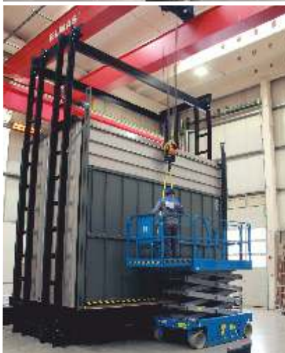
Etapele de premontaj ale ascensorului The preassembly stage of the installation
