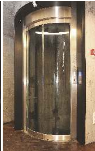
Ușile ascensorului Elevator doors
